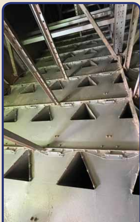
Прокладання кабелів системи виявлення пожежі
